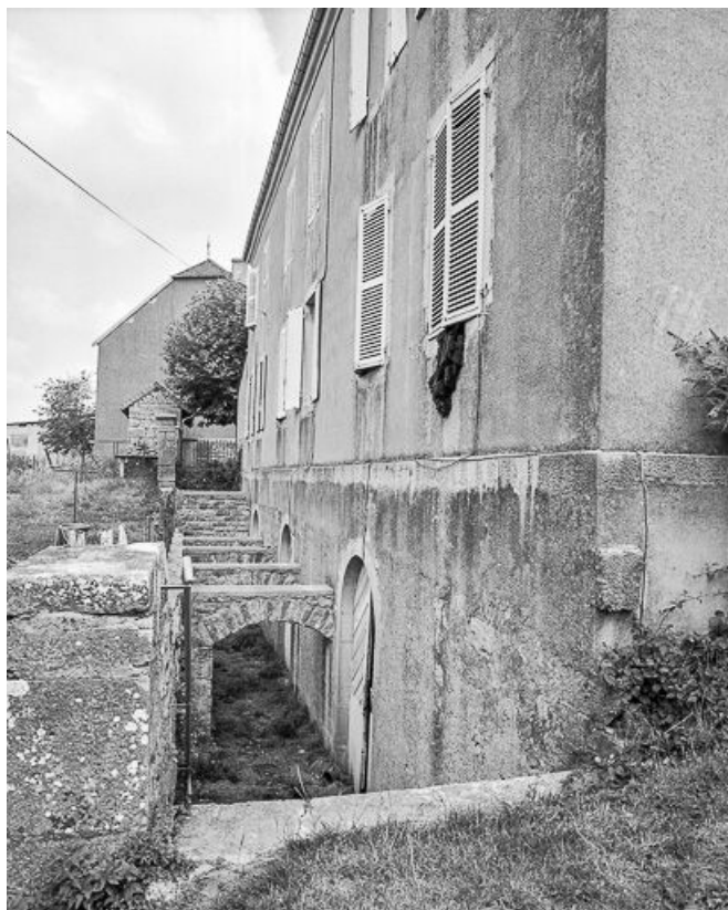
Détail du soubassement de la façade postérieure.
