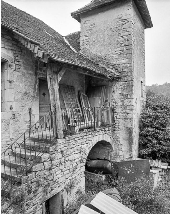
Auvent protégeant l'escalier.
