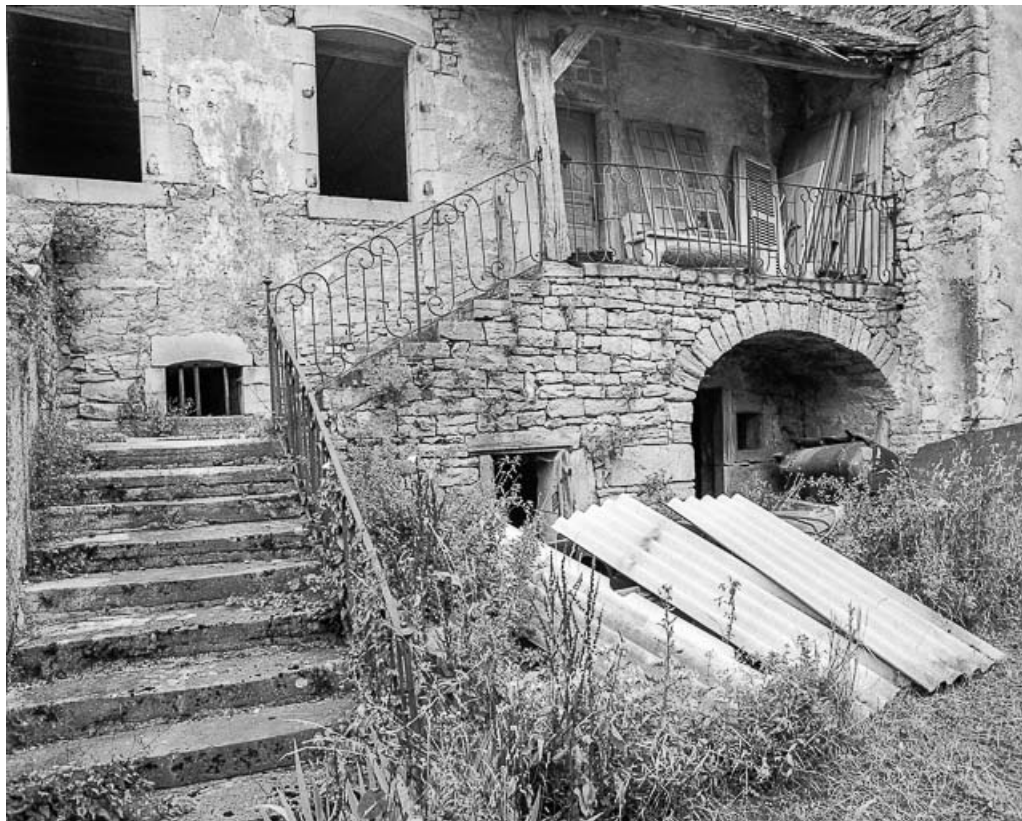
Détail de l'escalier.
