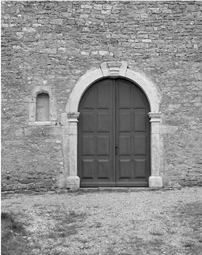
Portail de la façade antérieure.
