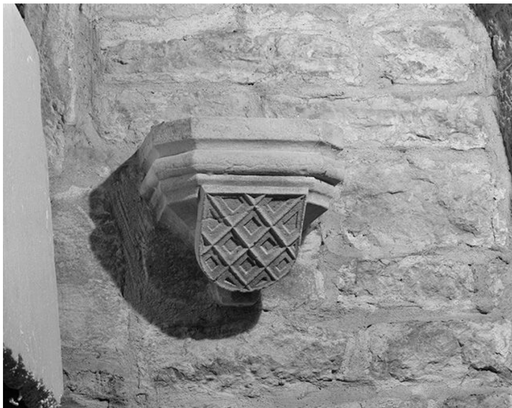
Intérieur : chapelle, mur est, console droite.
