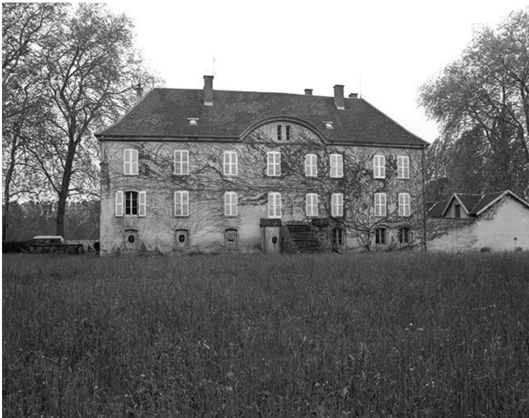
Façade antérieure, vue de face.
