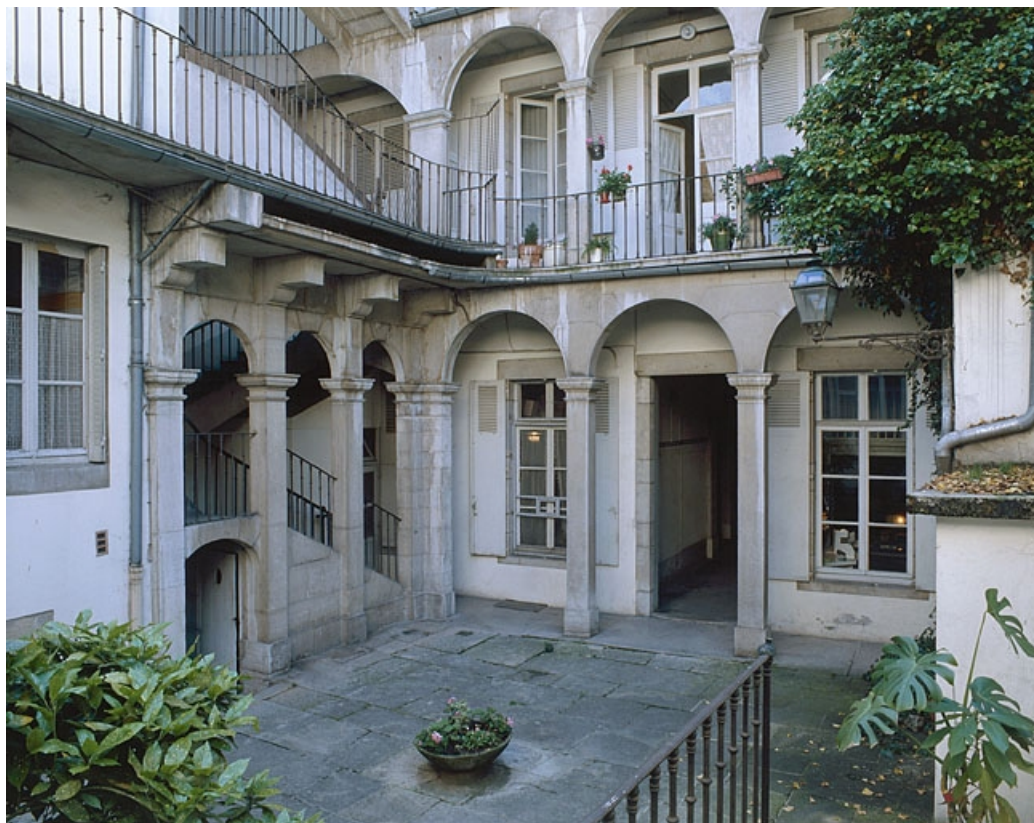
Façade sur la cour, détail.
