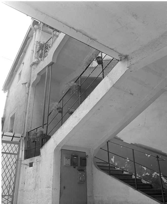
L'escalier ouvrant sur la cour.
