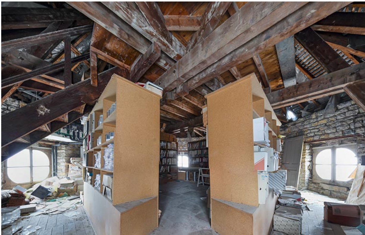
Comble au-dessus de l'ancienne salle d'attente.
