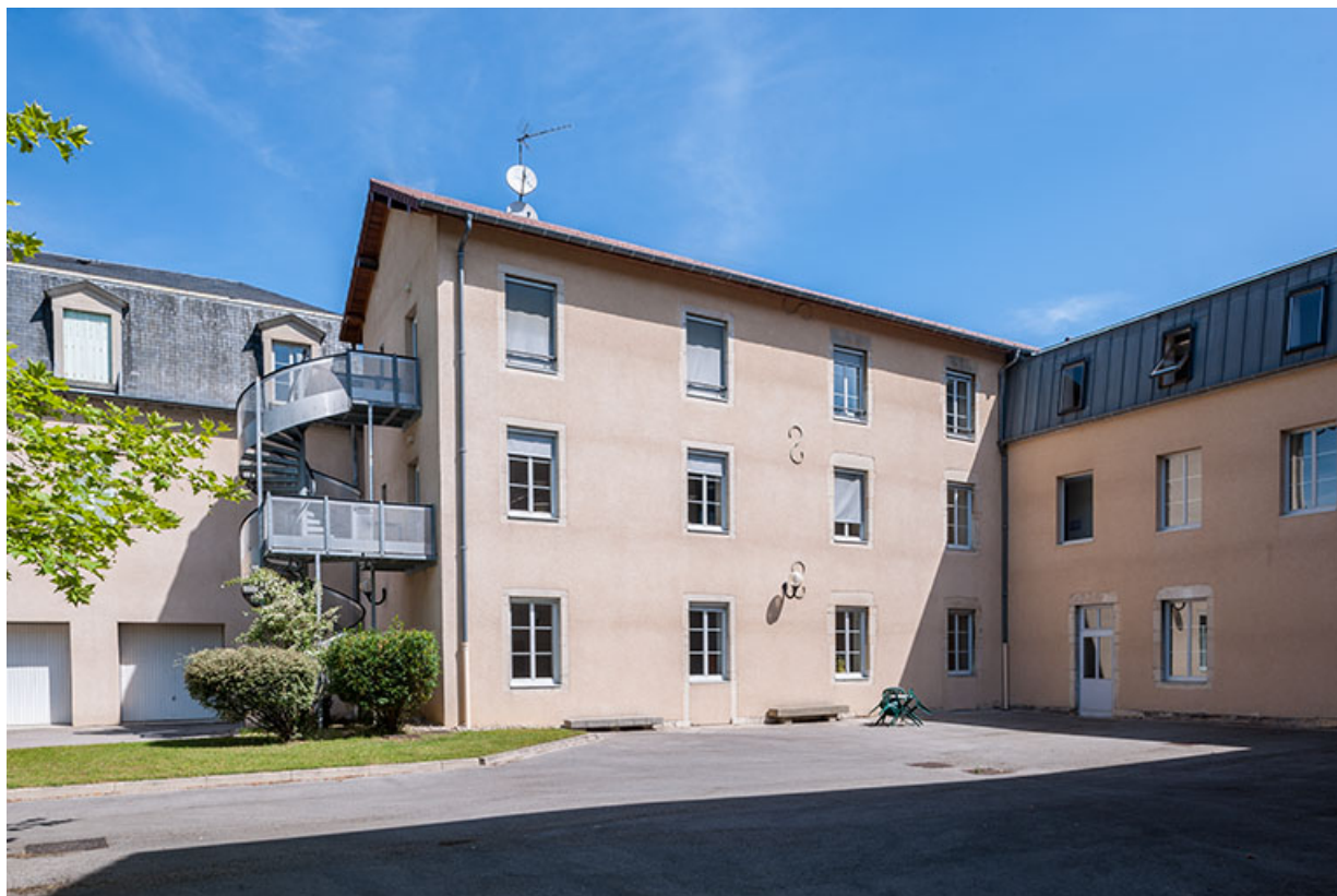
Façades postérieures des bâtiments administration.
