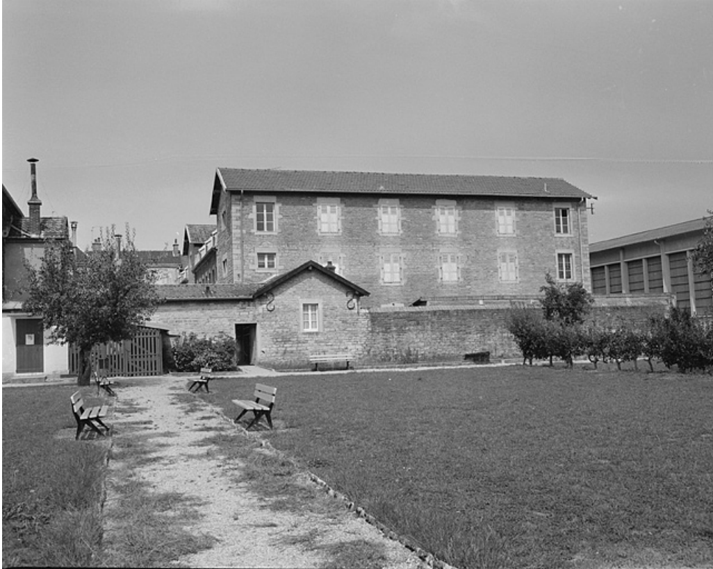
Façade latérale d'un des pavillons.
