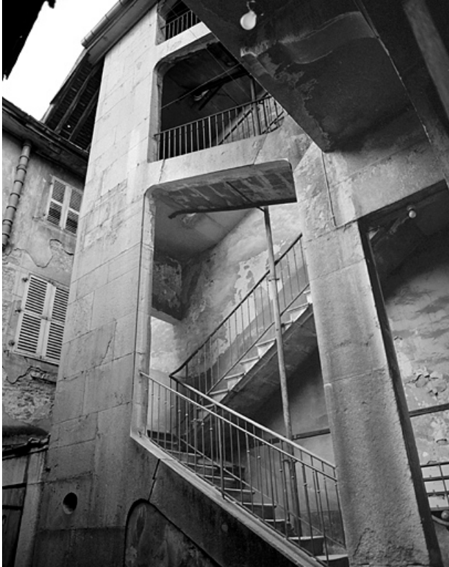
Maison, 16 rue Regard, escalier sur cour. 39, Lons-le-Saunier
