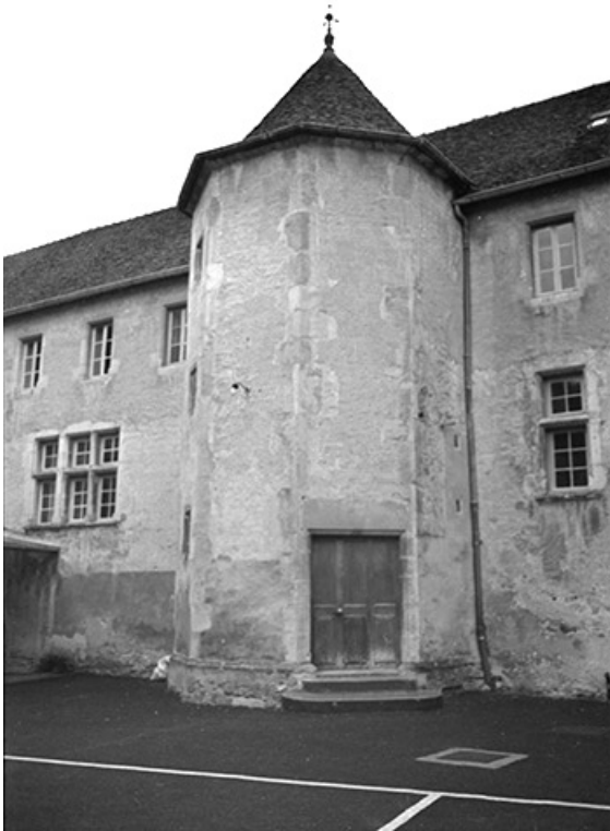
Tourelle d'escalier dans la cour.
