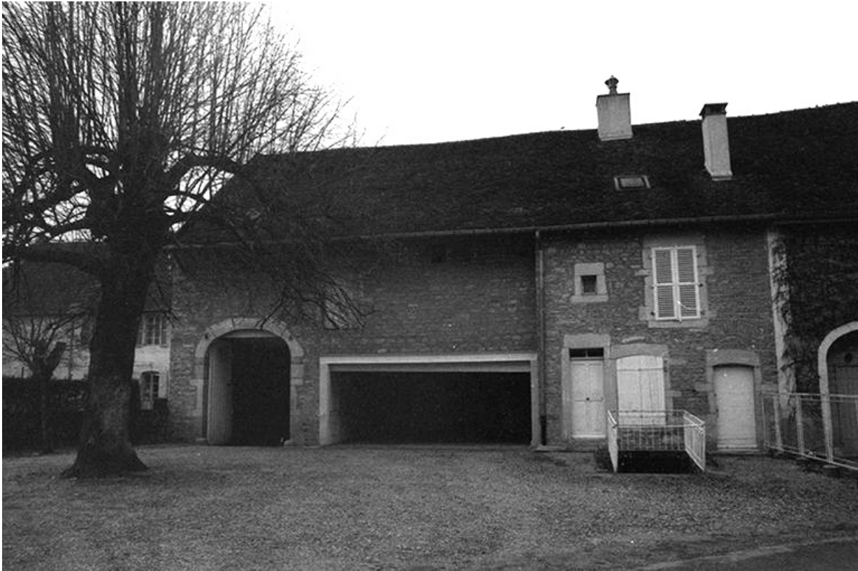
Maison de vigneron : façade antérieure.
