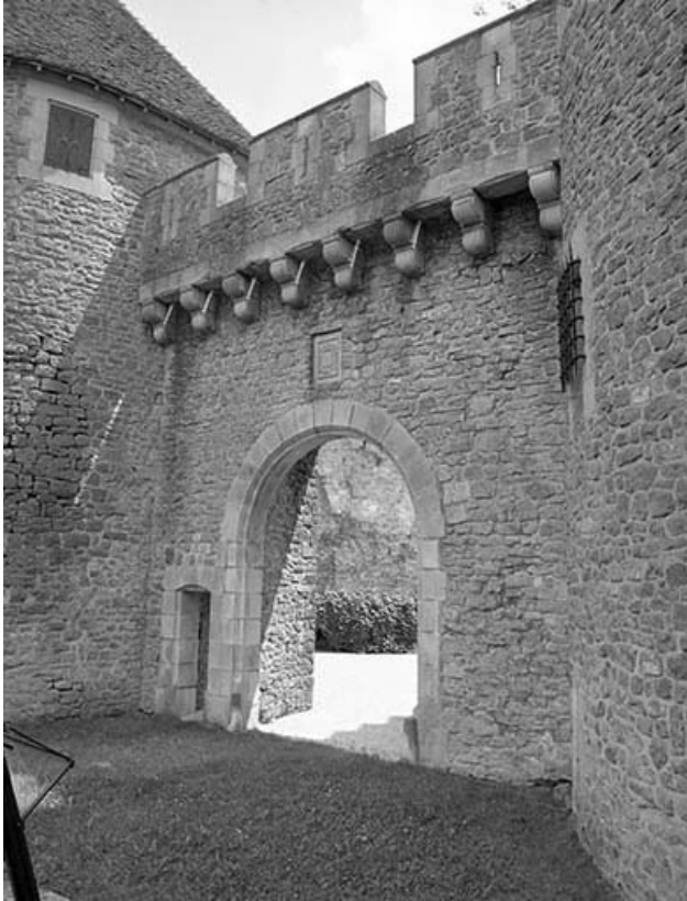
Portail nord : vue de trois quarts.
