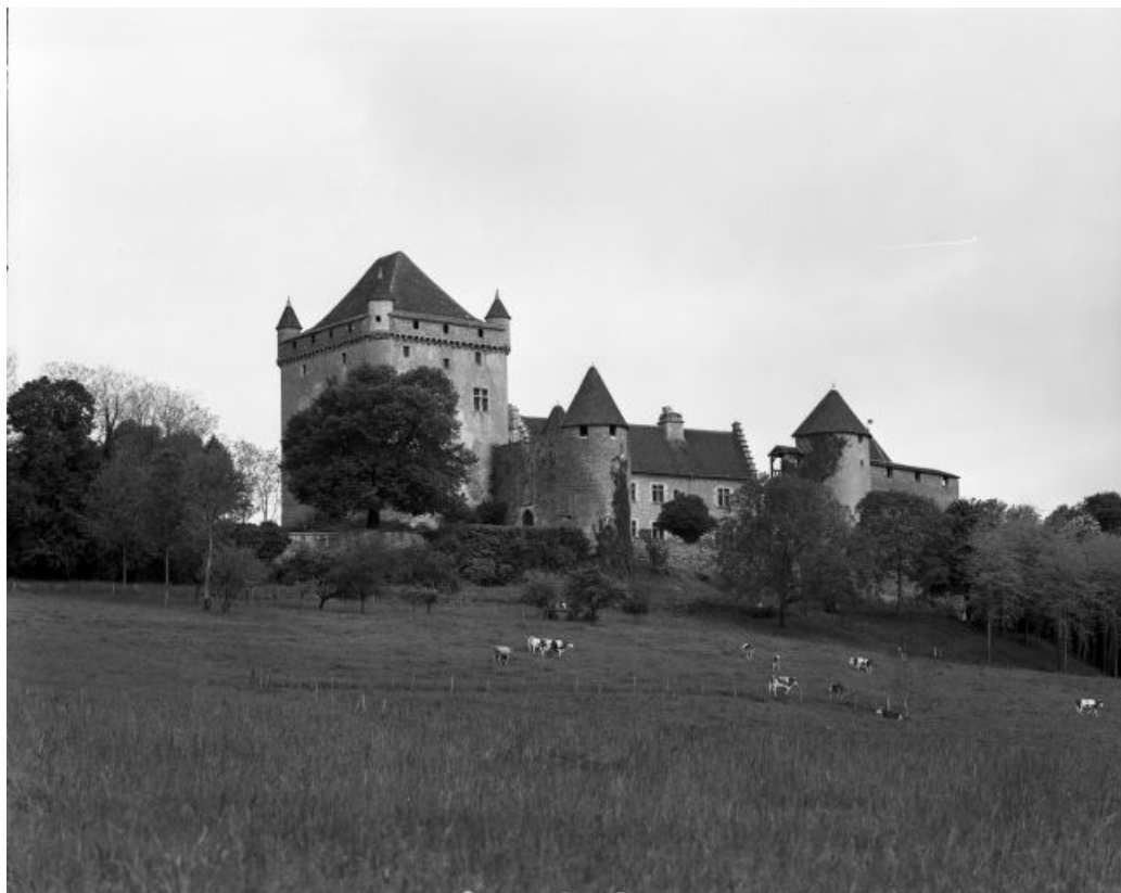
Face est, vue générale.
