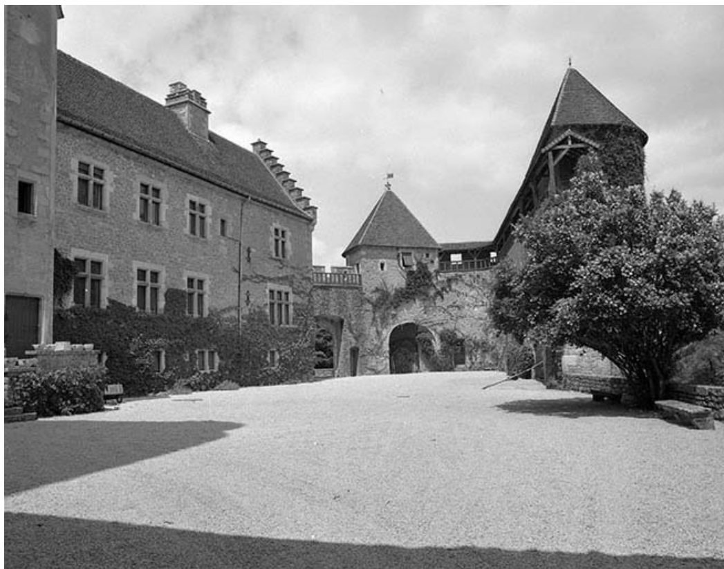
Vue générale de la cour intérieure.
