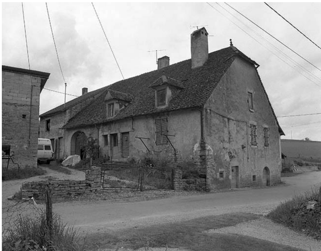
Façades antérieure et latérale droite.
