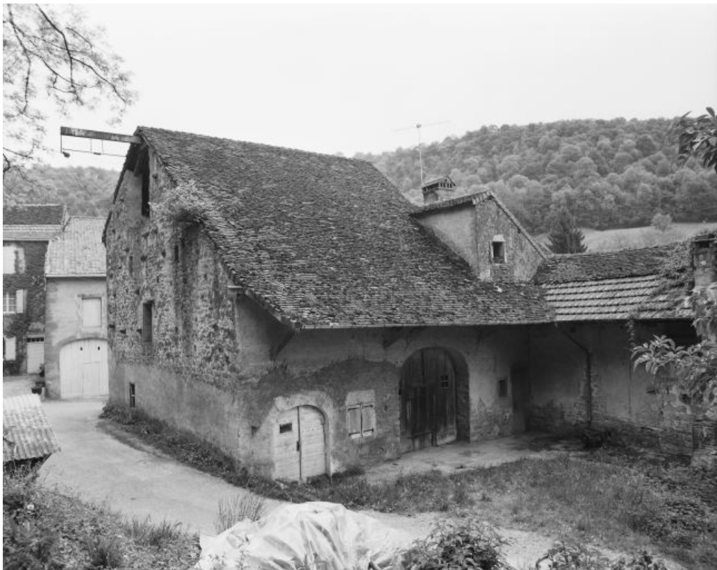
Façades antérieure et latérale gauche.
