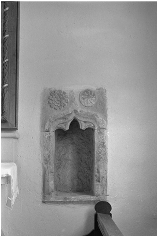
Lavabo en niche : vue de face.
