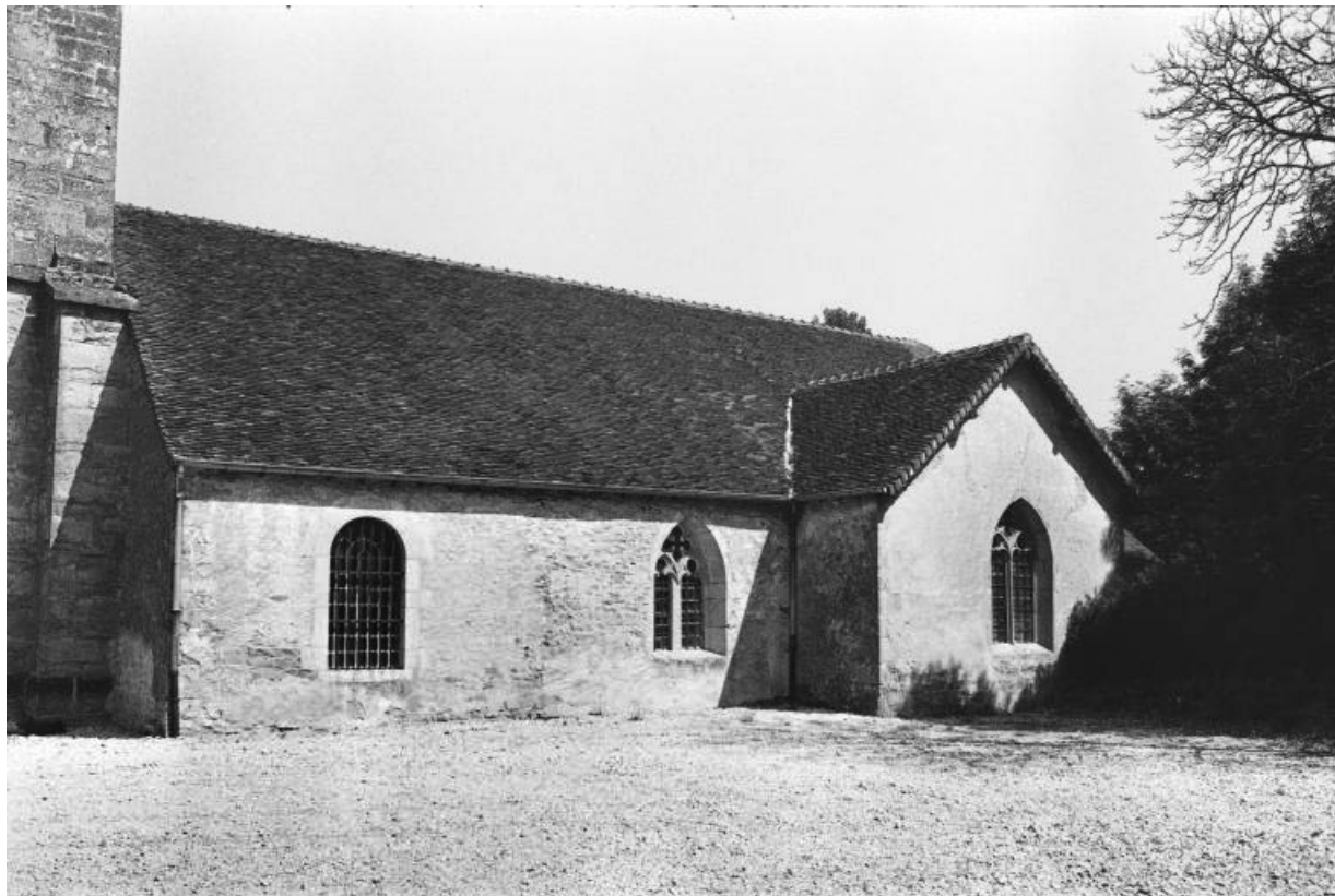
Façade latérale droite.
