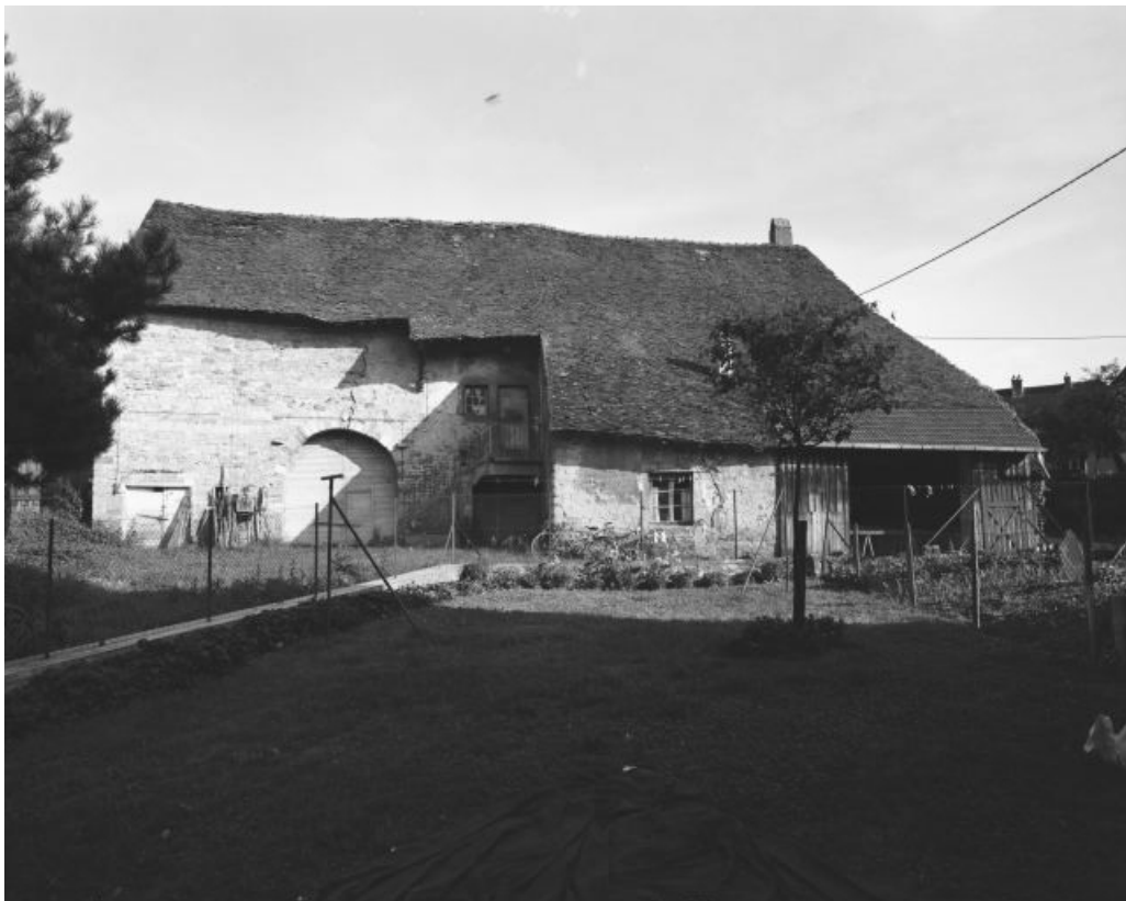
Façade antérieure vue de face.
