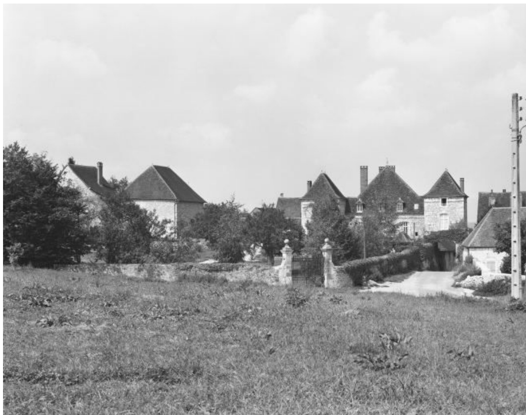
Vue générale depuis l'est.
