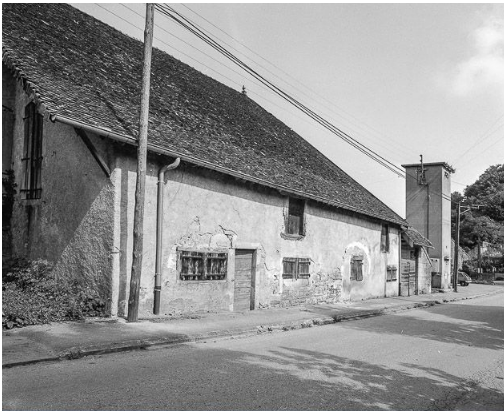
Façade sur rue, partie droite.
