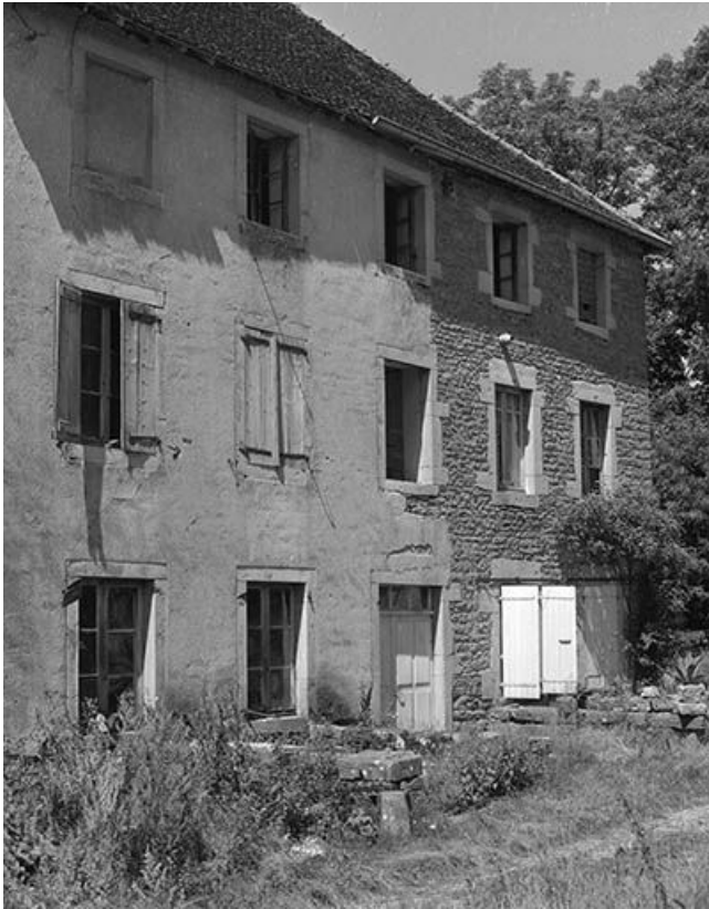
L'habitation : façade sur cour, détail.
