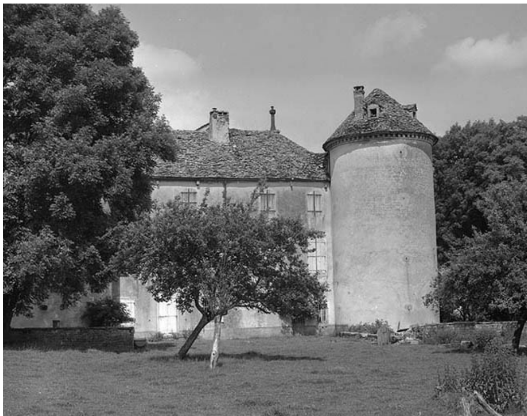
Tour de l'angle Sud-Est.
