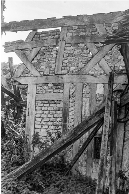
Ferme cadastrée 1956 A1 142-143 : détail du mur. 39, Fontainebrux
