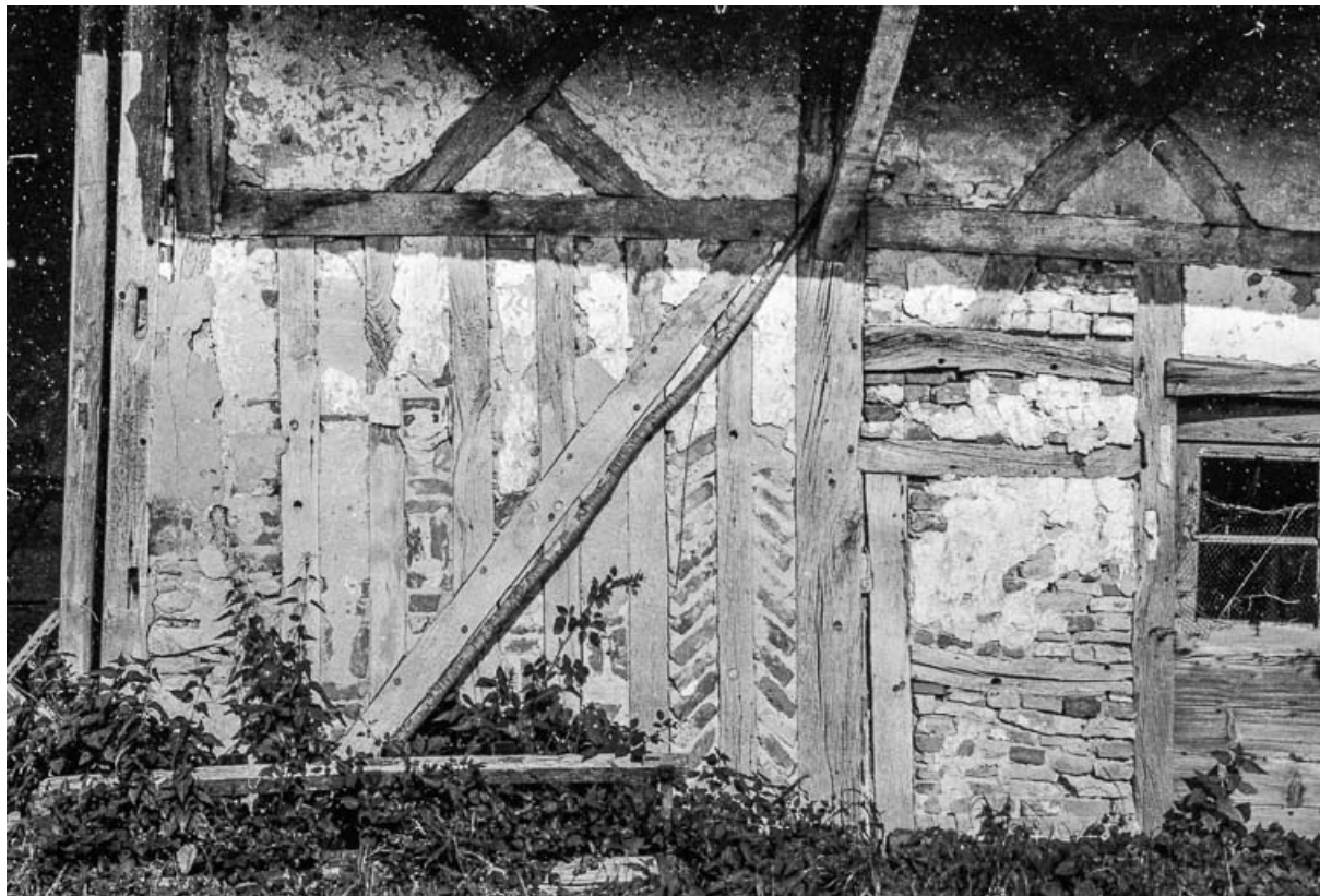
Ferme cadastrée 1956 A1 142-143 : détail du mur.
