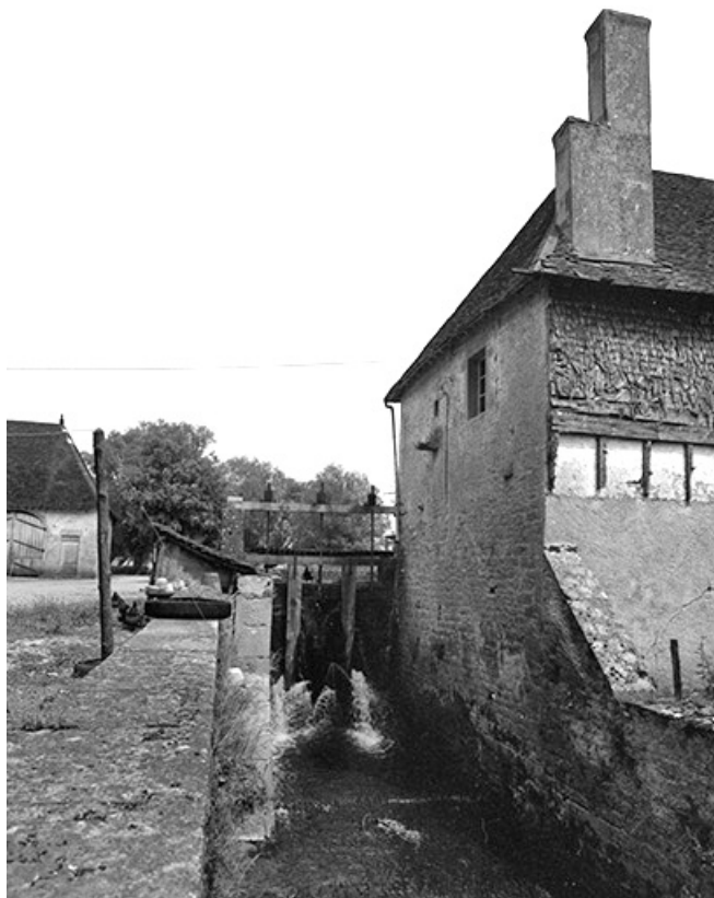
Vannes du canal.
