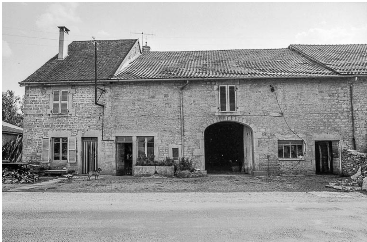
Ferme cadastrée A3 195 : façade antérieure.
