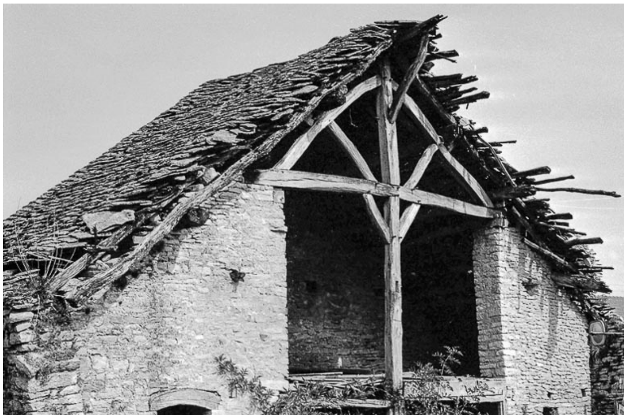
Ferme cadastrée B3 256 : toiture.
