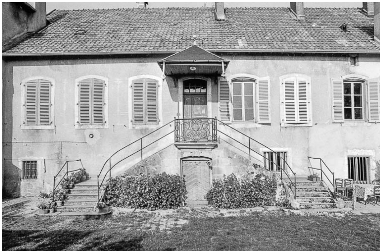
Façade antérieure et escalier à double volée.
