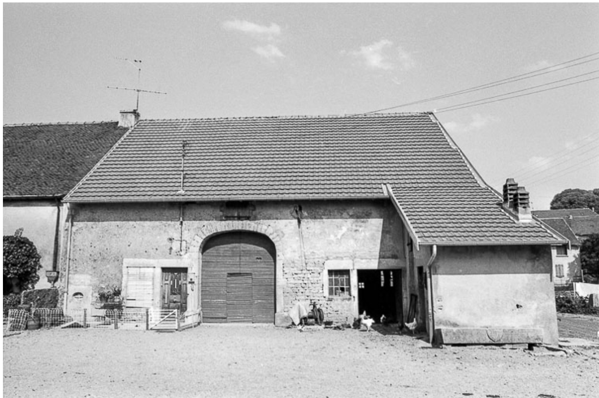
Ferme cadastrée D2 214 : façade antérieure.
