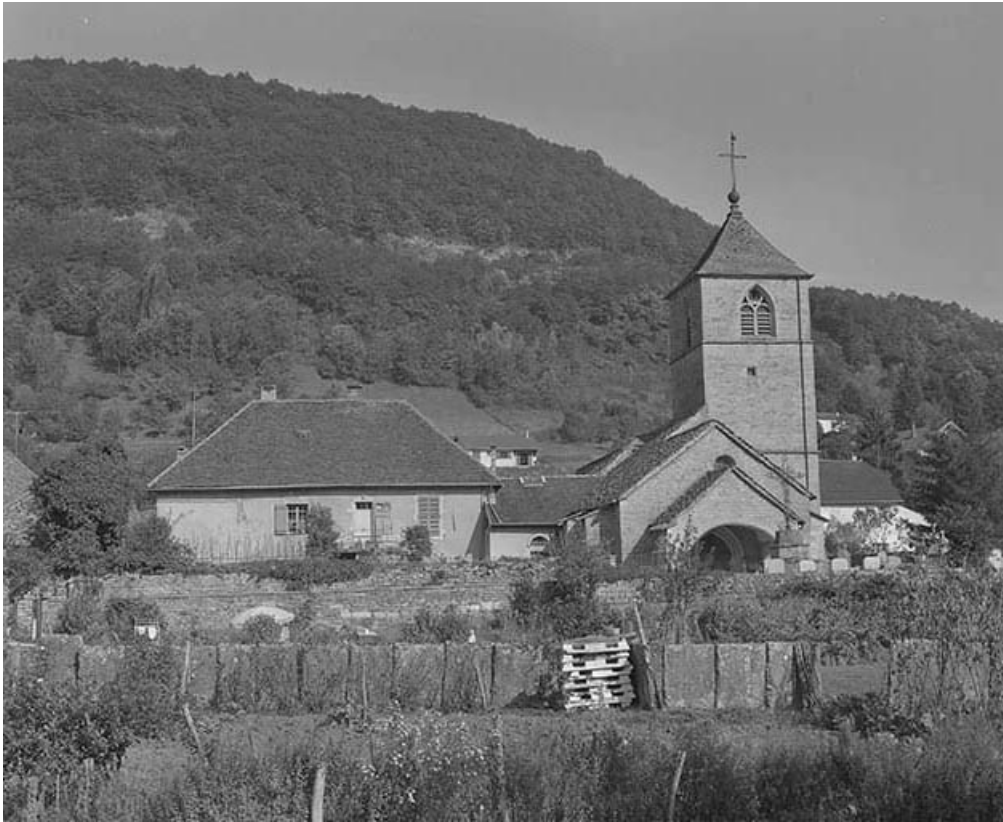
Extérieur : façade antérieure.
