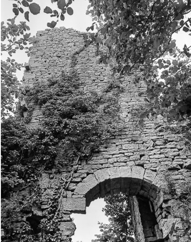
Vue extérieure du donjon.
