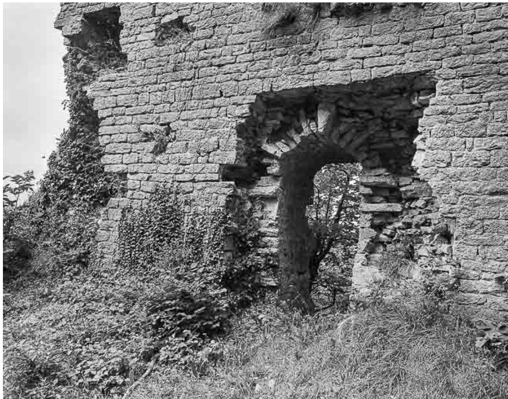
Vue extérieure du donjon : détail d'une porte.
