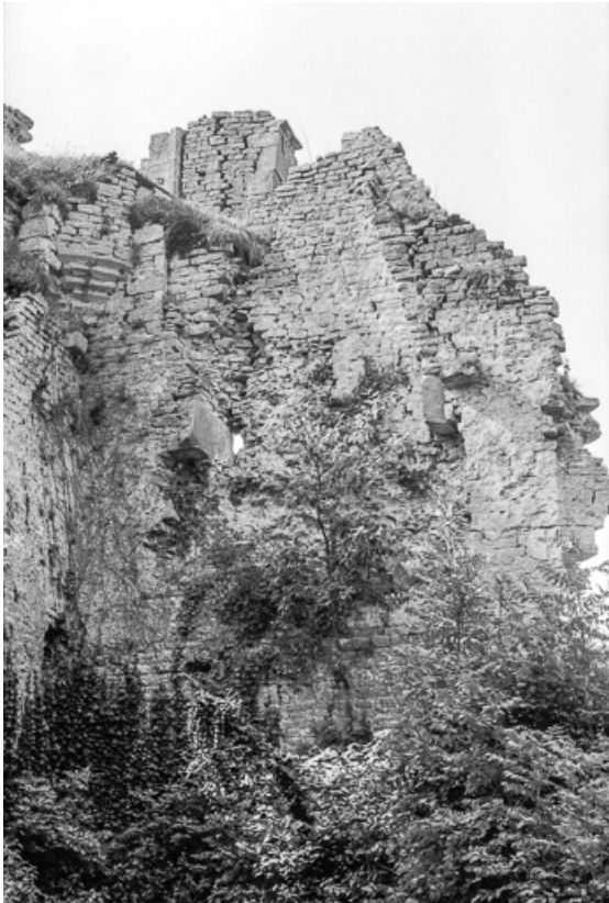
Vue extérieure du donjon.
