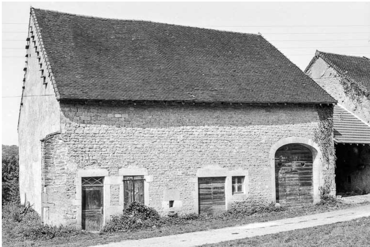
Ferme cadastrée ZK 35 : façade antérieure.
