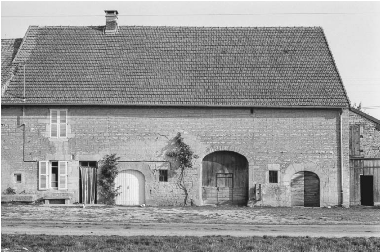
Ferme cadastrée A3 564 : façade antérieure.
