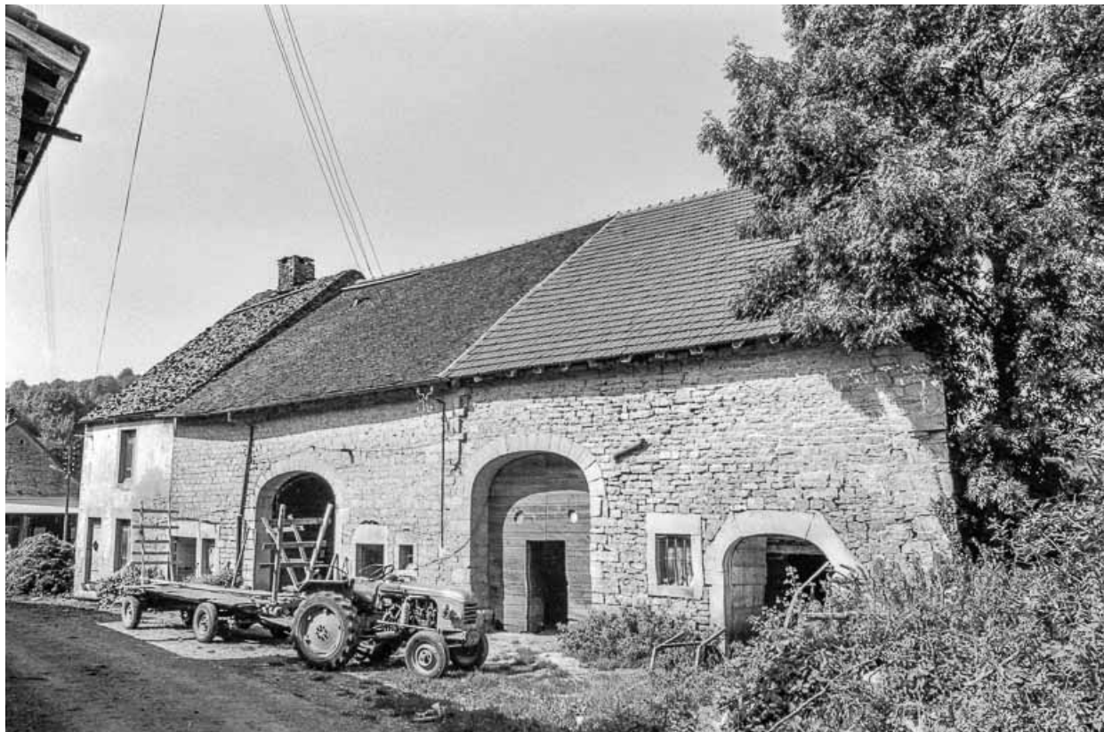
Ferme cadastrée ZK 40 : façade antérieure.
