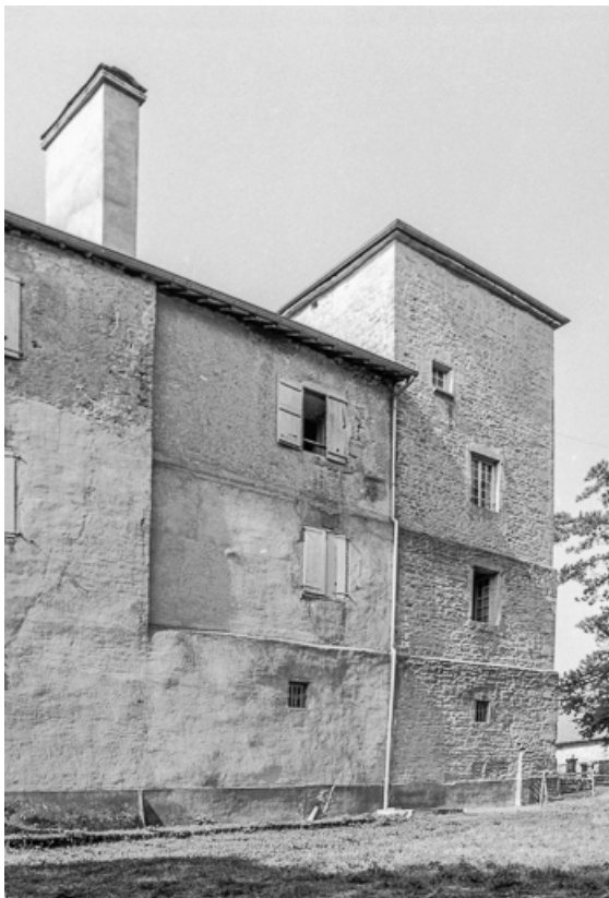
Face nord (la tour).
