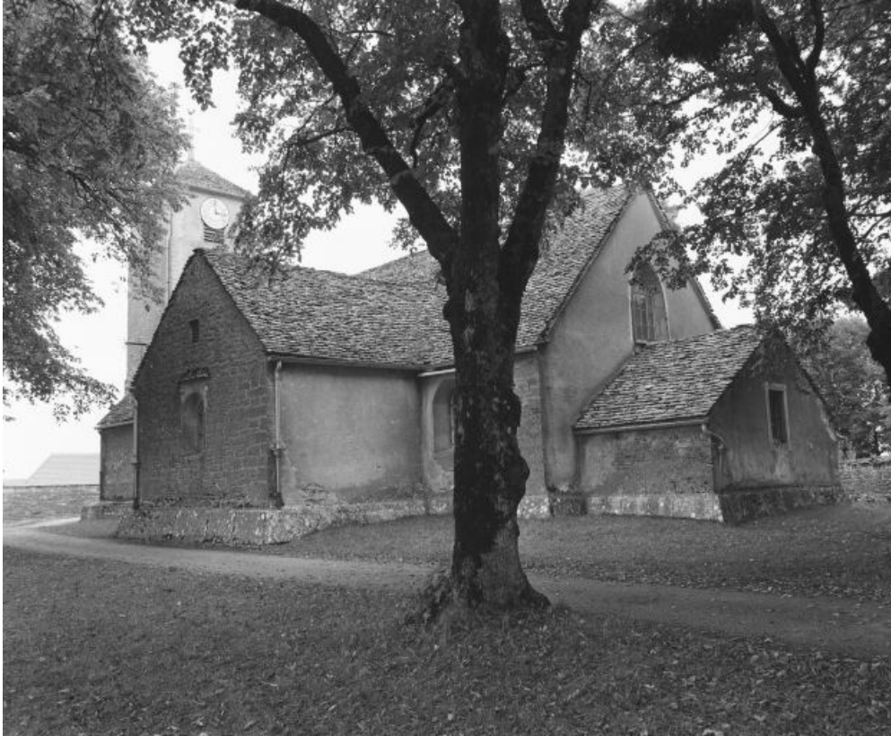
Vue d'ensemble derrière le chevet.
