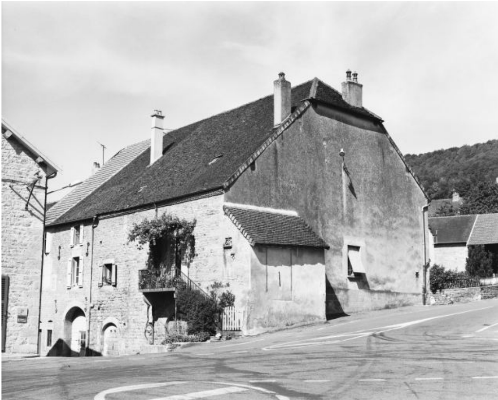
Façades postérieure et latérale gauche.
