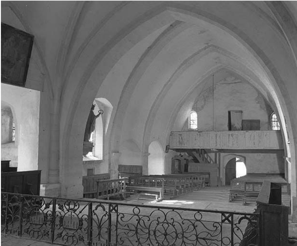
Intérieur : élévation droite vue depuis le chœur.
