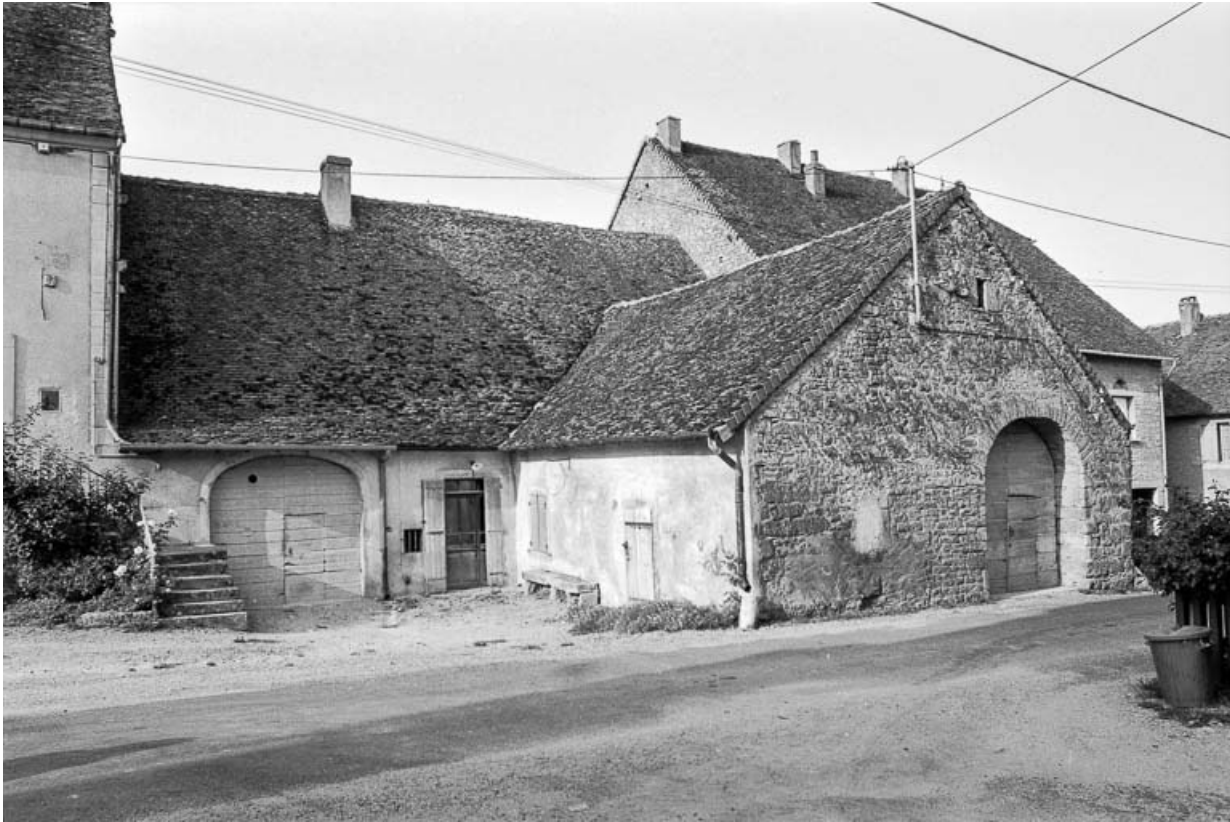
Ferme cadastrée AD 327 : façades antérieures.
