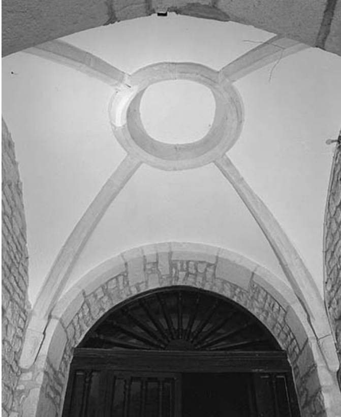
Intérieur : voûte du vestibule.
