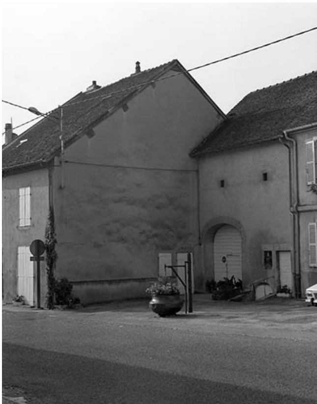
Façade antérieure, partie droite.
