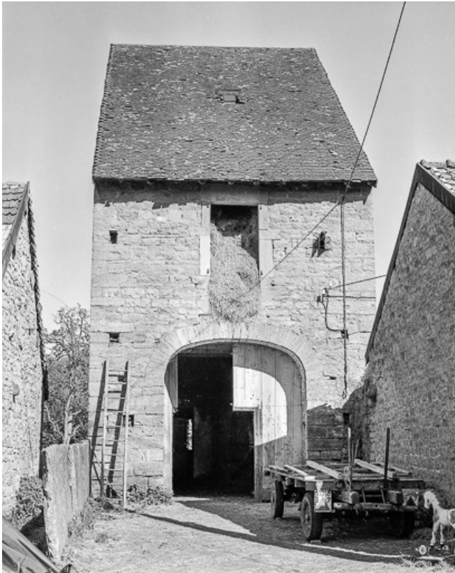
Ferme cadastrée AI 74 : grange. 39, Montaigu
