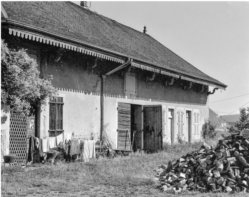
Maison cadastrée AC 251 ; façade postérieure. 39, Montaigu
