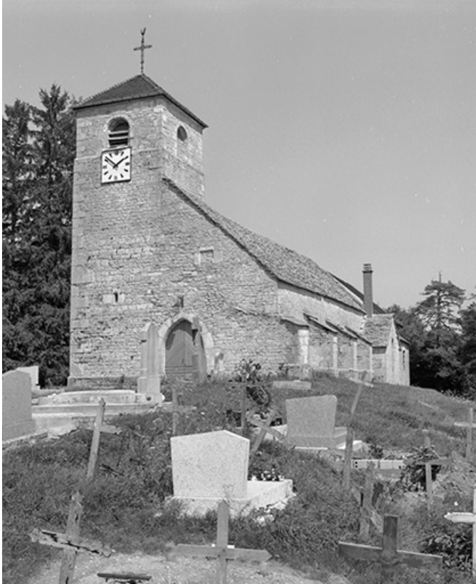
Façade antérieure : vue rapprochée.
