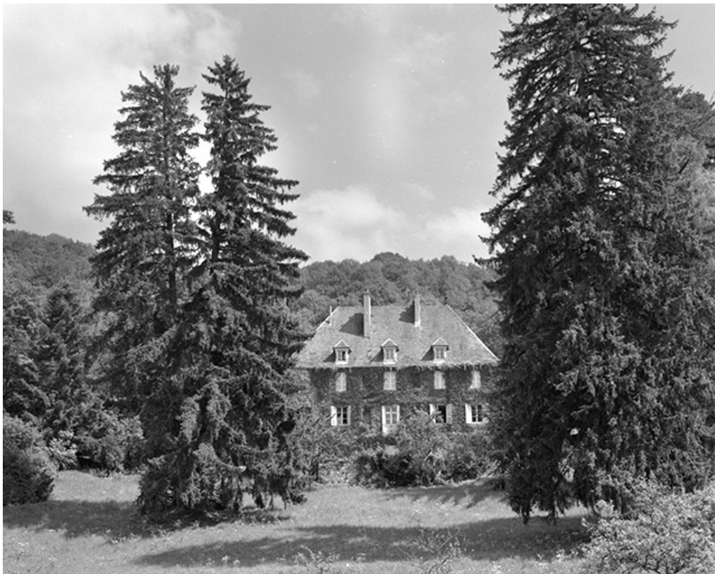
Le logis : façade occidentale vue de face.
