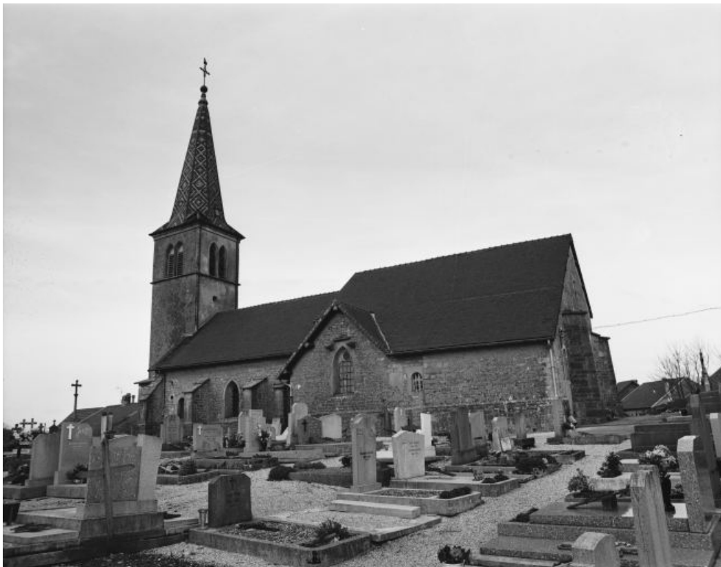
Façade latérale droite.
