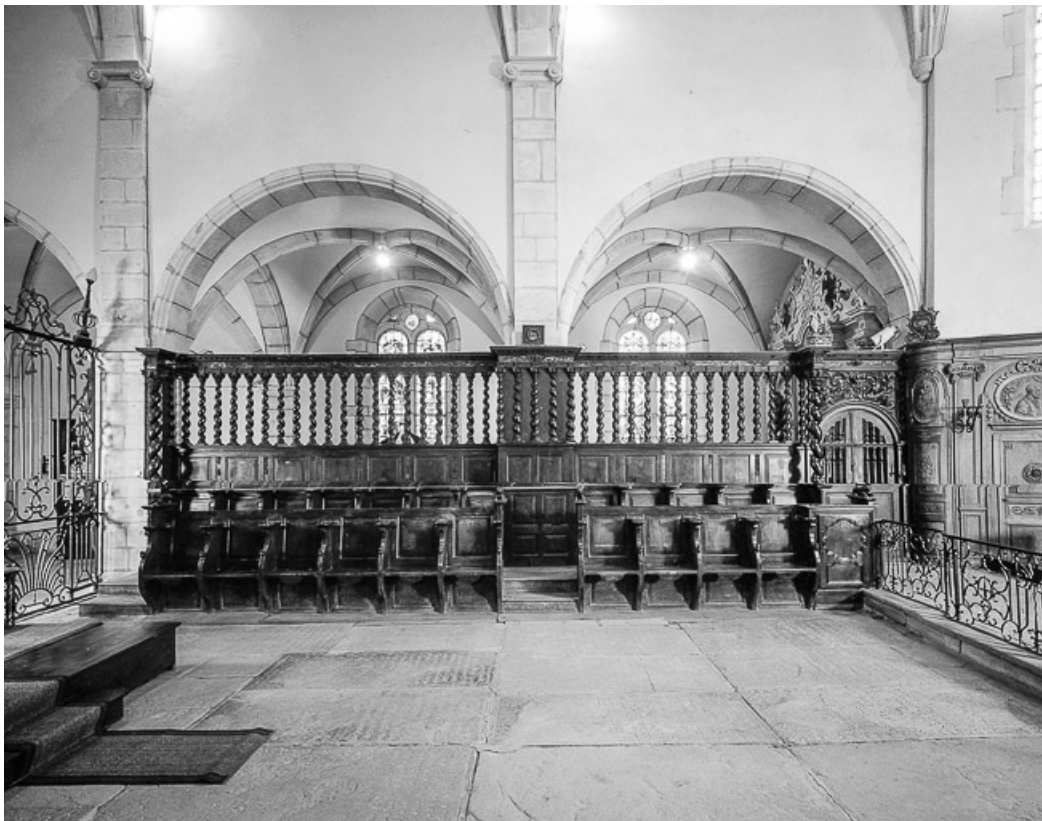
Intérieur : avant-choeur élévation gauche.
