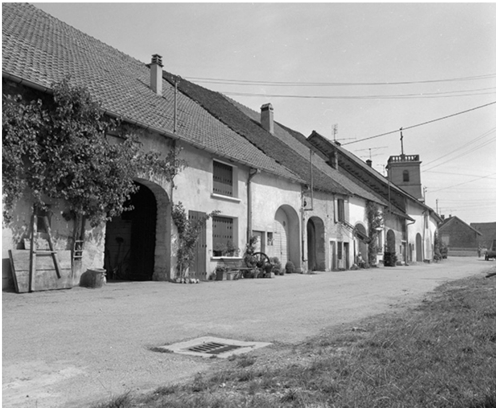
Fermes : façades sur rue.
