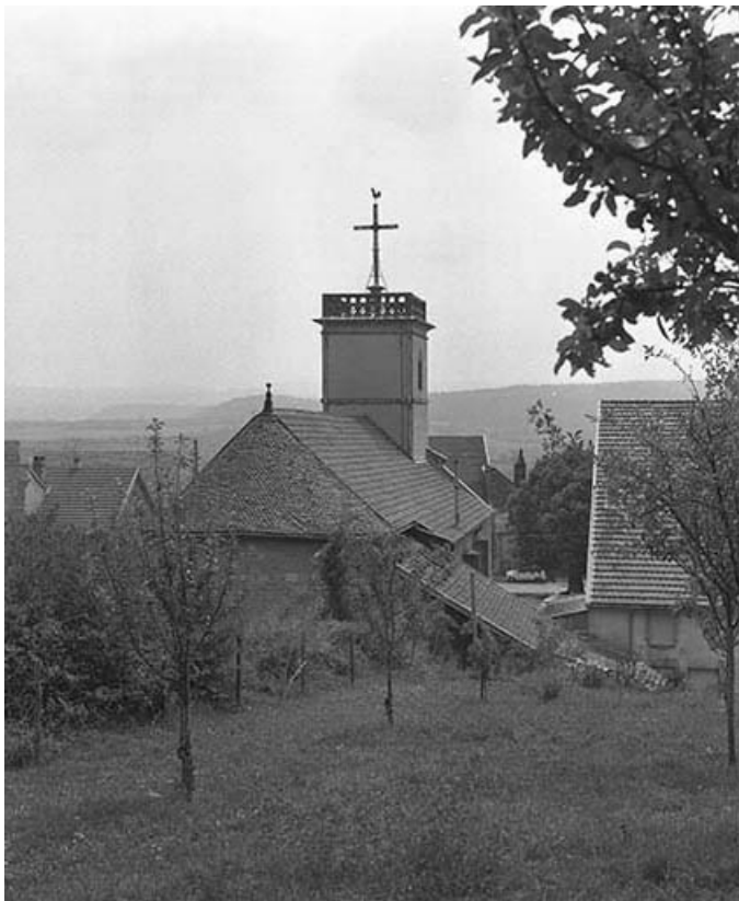
Extérieur : abside, vue de trois quarts.
