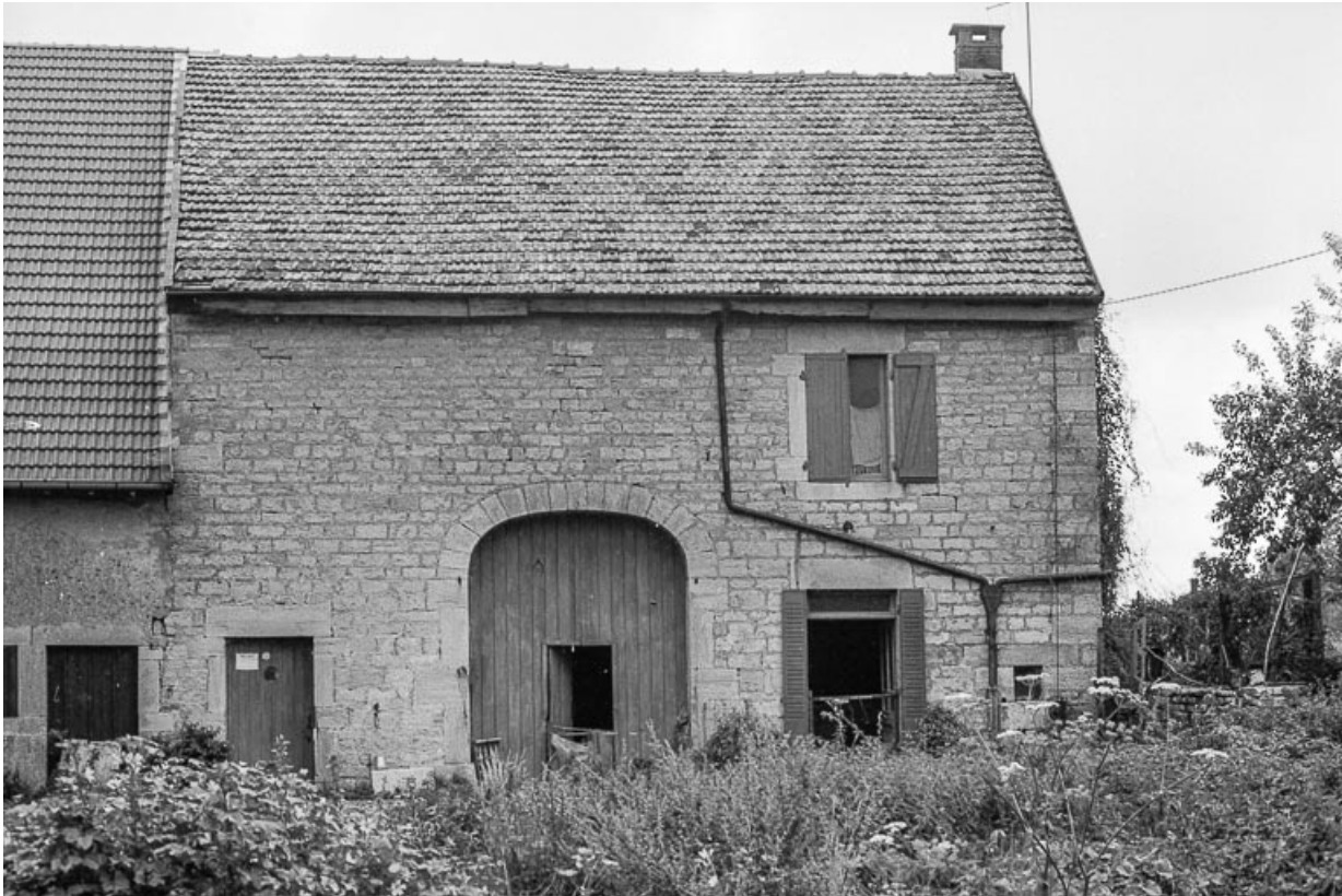
Façade antérieure : vue rapprochée.
