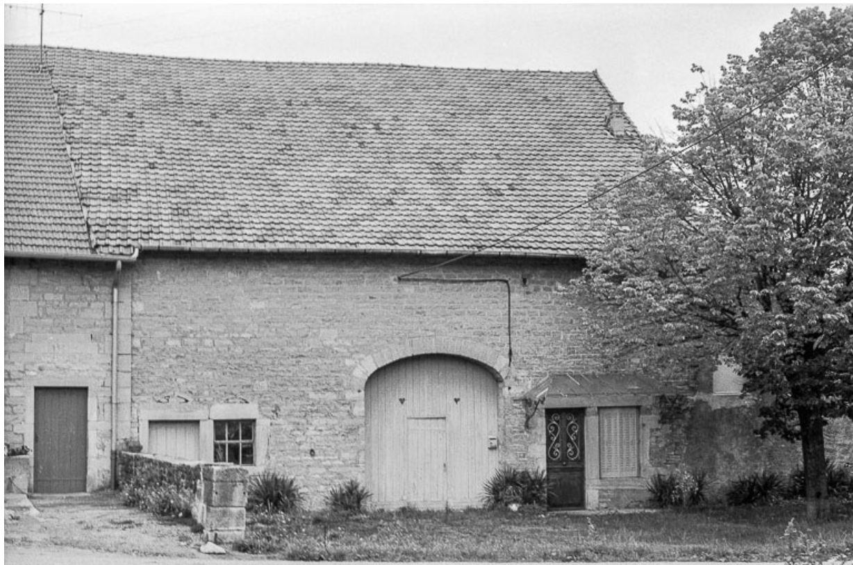
Ferme cadastrée B2 181 : façade antérieure.
