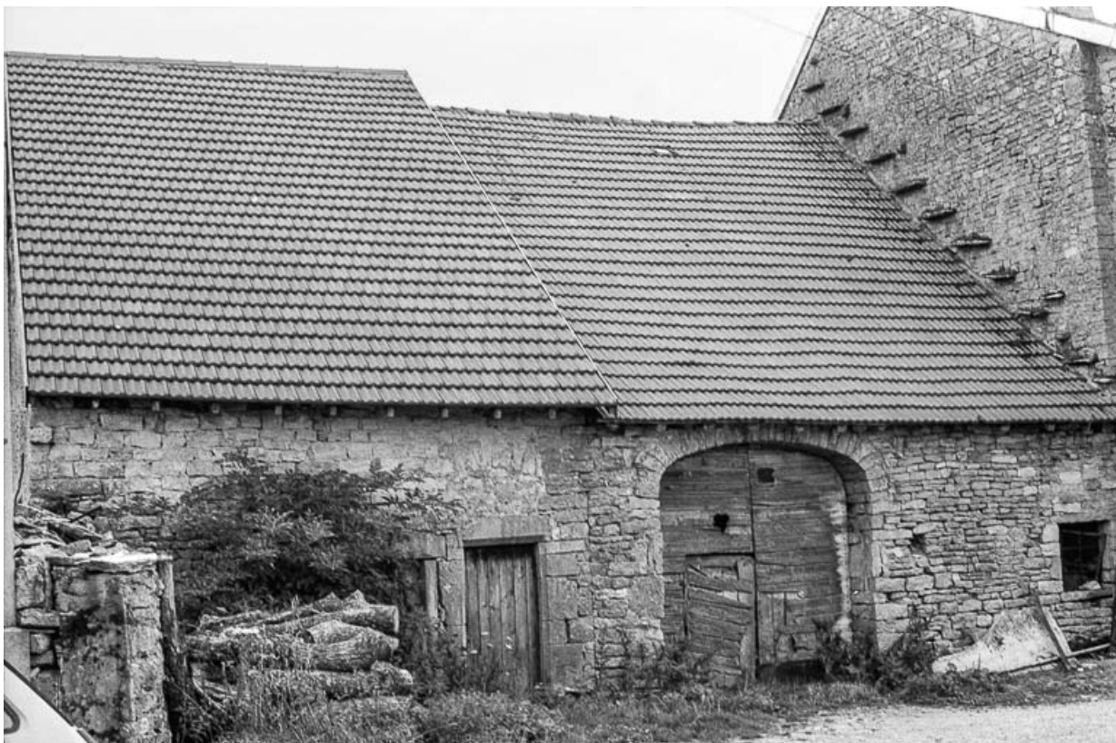
Ferme cadastrée B2 176 : façade postérieure. 39, Briod
