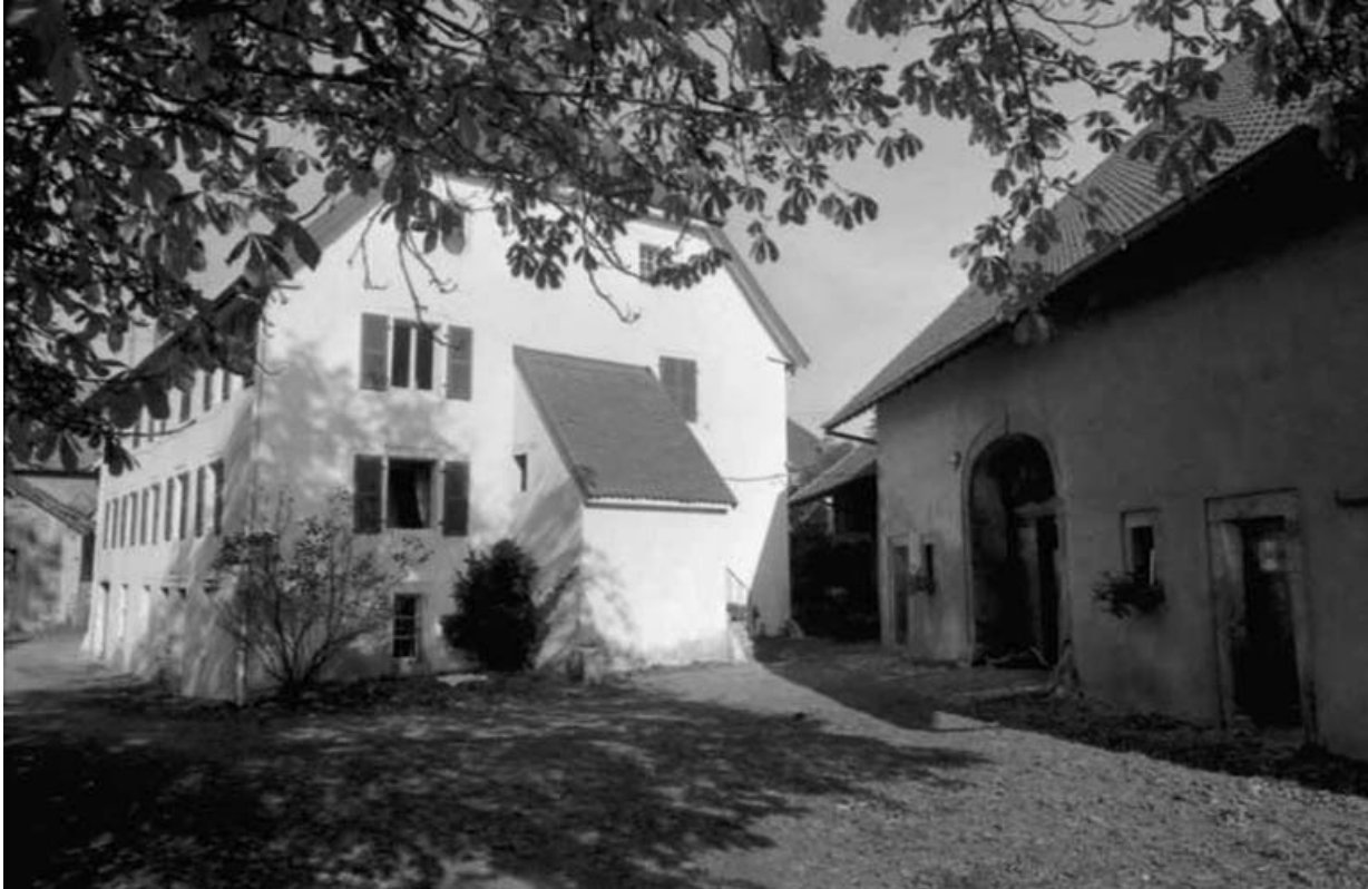
Pignon droit de l'habitation et partie agricole.
