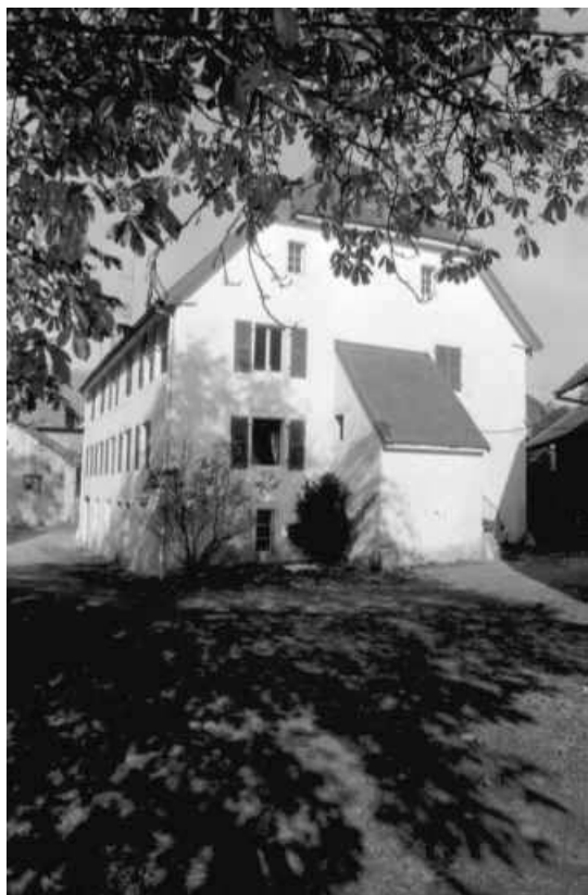
Pignon droit de l'habitation actuelle.
