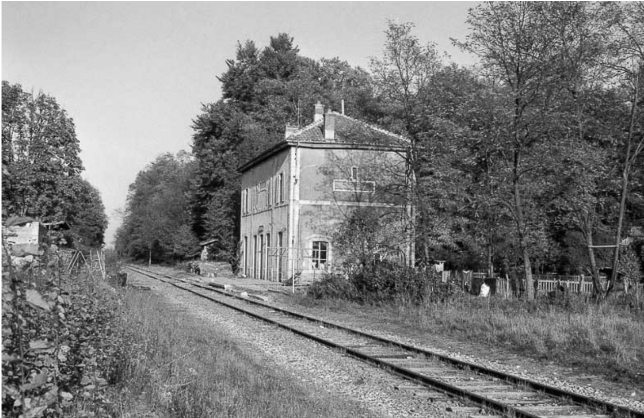
Façade sur voie.
