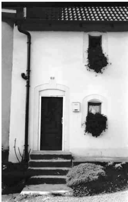
Elévation antérieure : détail.
