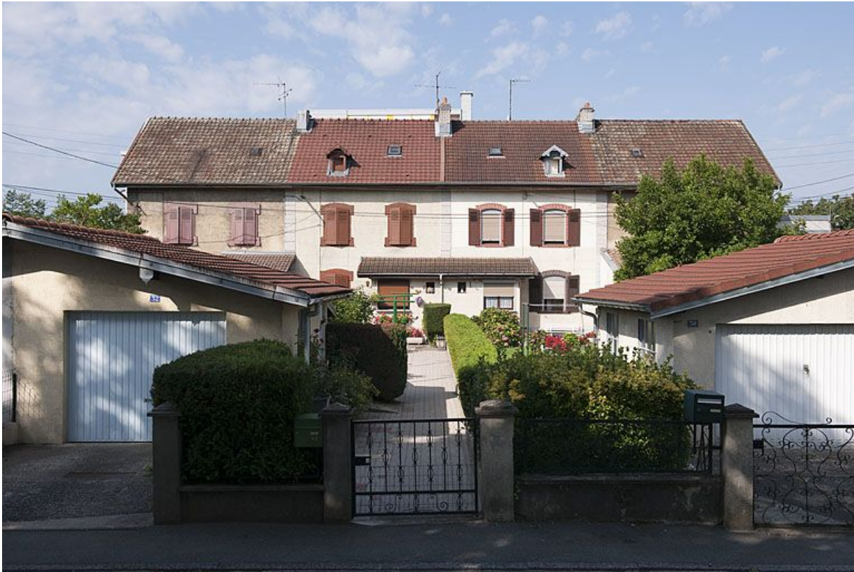
Façade ouest d'une habitation.
