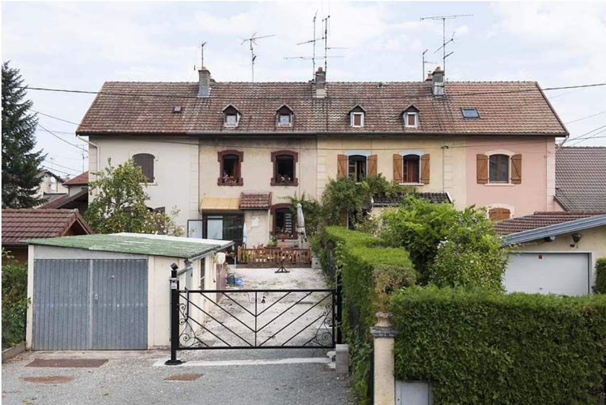
Habitation à 8 logements. Vue de face.
