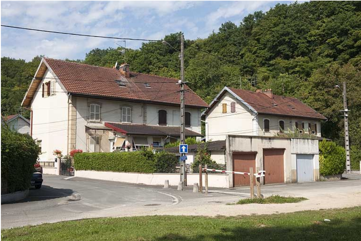
Habitations à 4 logements vues de trois quarts.
