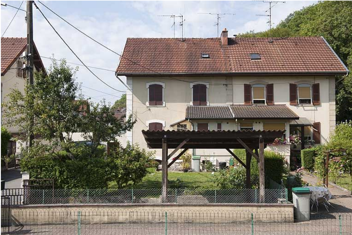
Face est d'une habitation à 4 logements.
